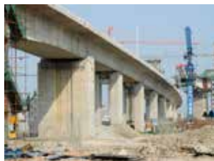
道路、桥梁施工
