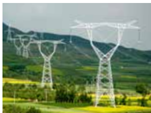
水利、电力建设
